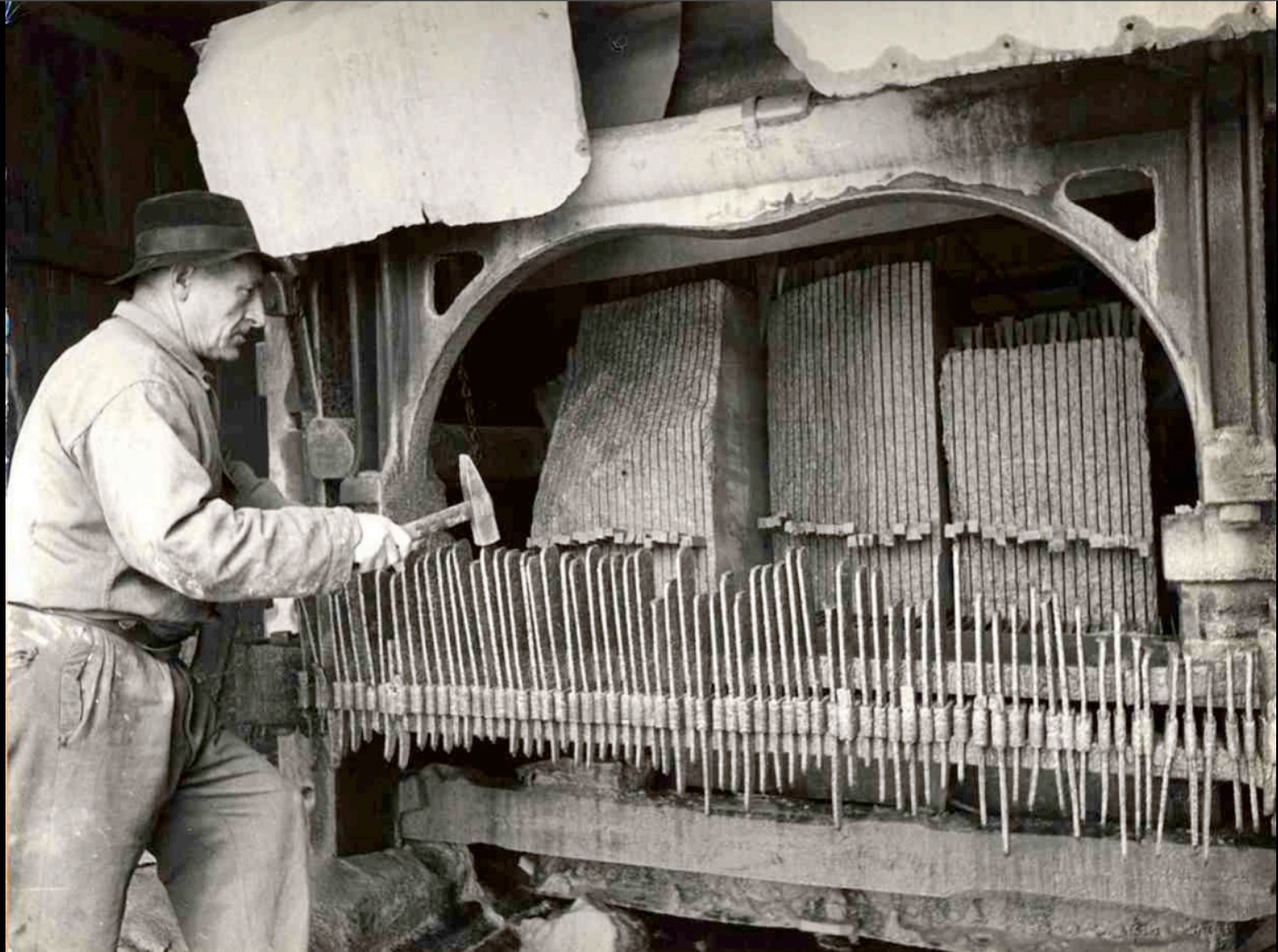
SGTI: Avenza - Laboratorio marmi - Segheria - Telaio multilame
