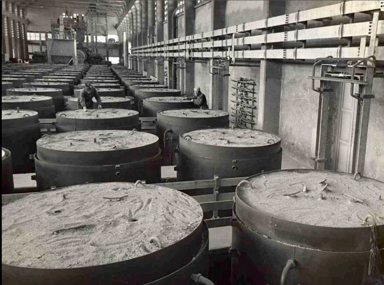
SGTI: Avenza - Stabilimento per il trattamento dell'azoto - Impianto cianamide - Interno
