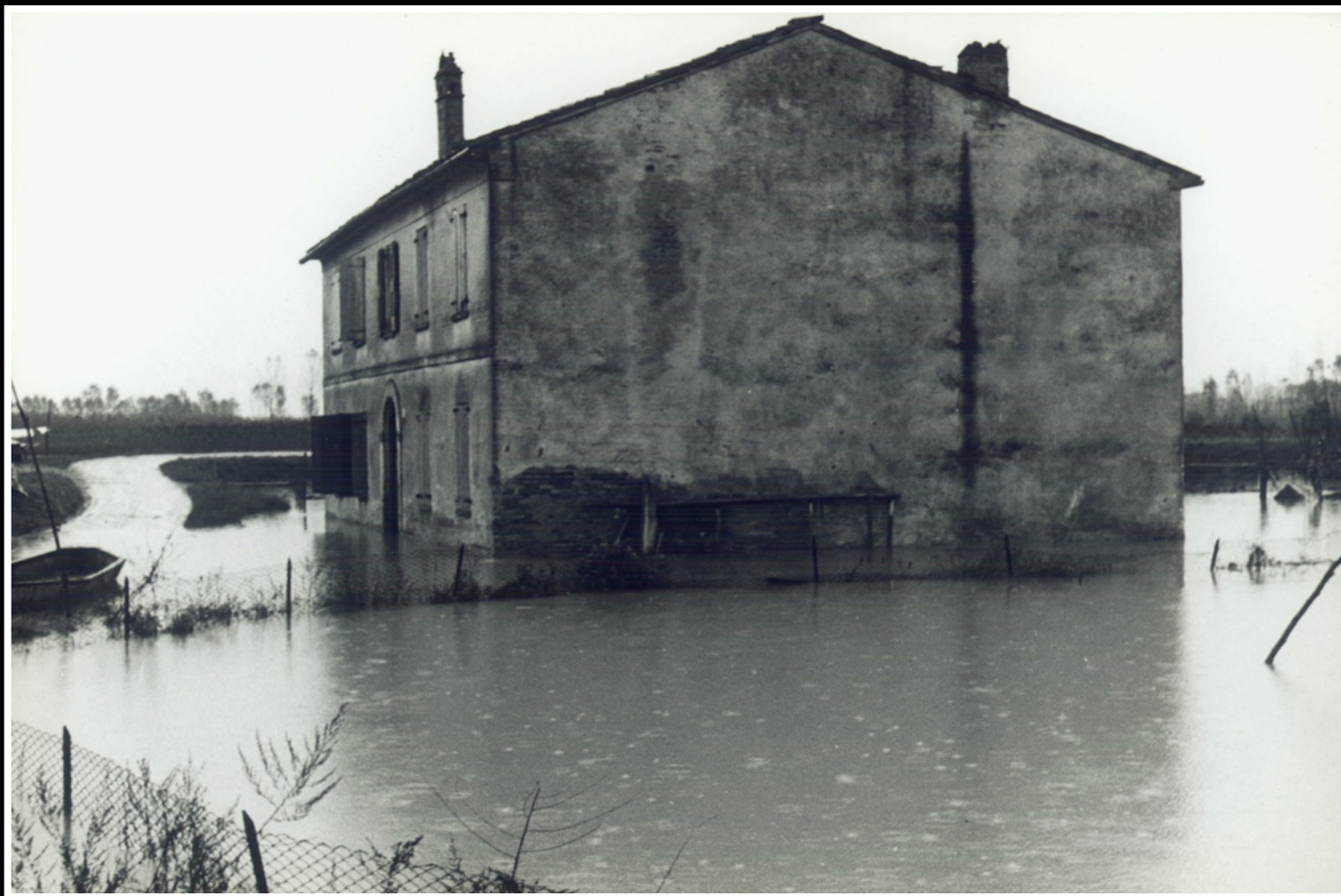
Acquanegra sul Chiese - Alluvione - Cascina Fornace
